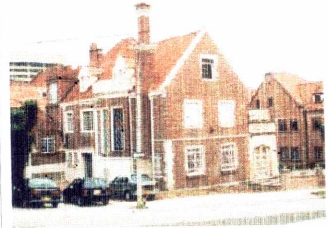
ALTERACIONES A LA EDIFICACION ORIGINAL VISIBLES DESDE EL EXTERIOR :
